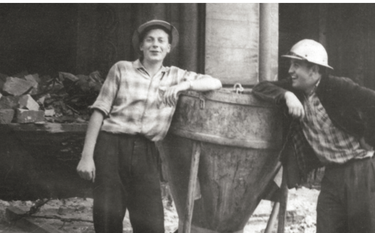
Bauhelfer Eberhard Diepgen (links) auf der Baustelle der neuen Kaiser-Wilhelm-Gedächtnis-Kirche
