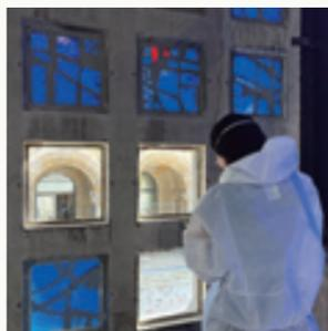
der Waben) hat der Korrosionsprozess nach Jahren vermehrt Betonstücke wie auch Gläser abplatzen lassen. Nach der Sanierung der Kapelle 2016/2017 wurden unter der Leitung des Architekten Steffen Obermann und durch die Finanzierung
