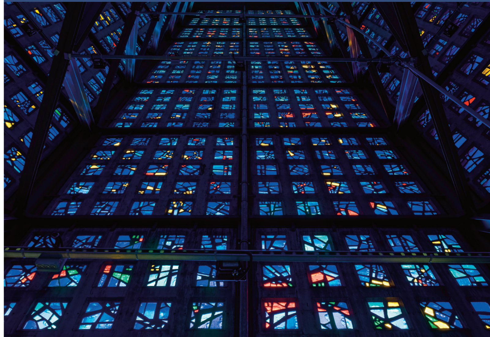
Glockenturm, Innenansicht mit Blick auf die Betonglaswand, 2020
