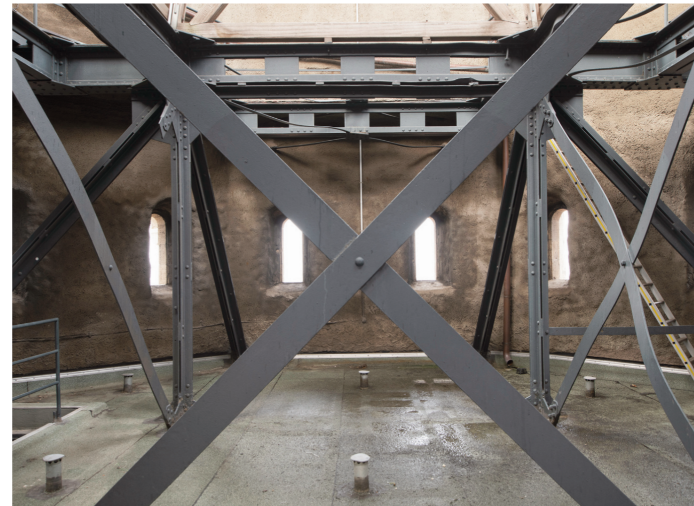
Blick in die ehemalige Glockenstube des Alten Turmes
