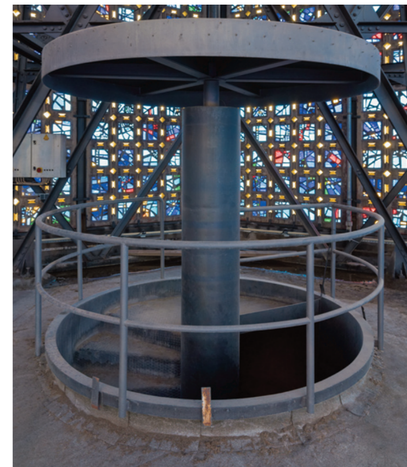
Ausgang innerhalb des Glockenturms. Hier sind die Fenster mit Schallöffnungen zu sehen.
