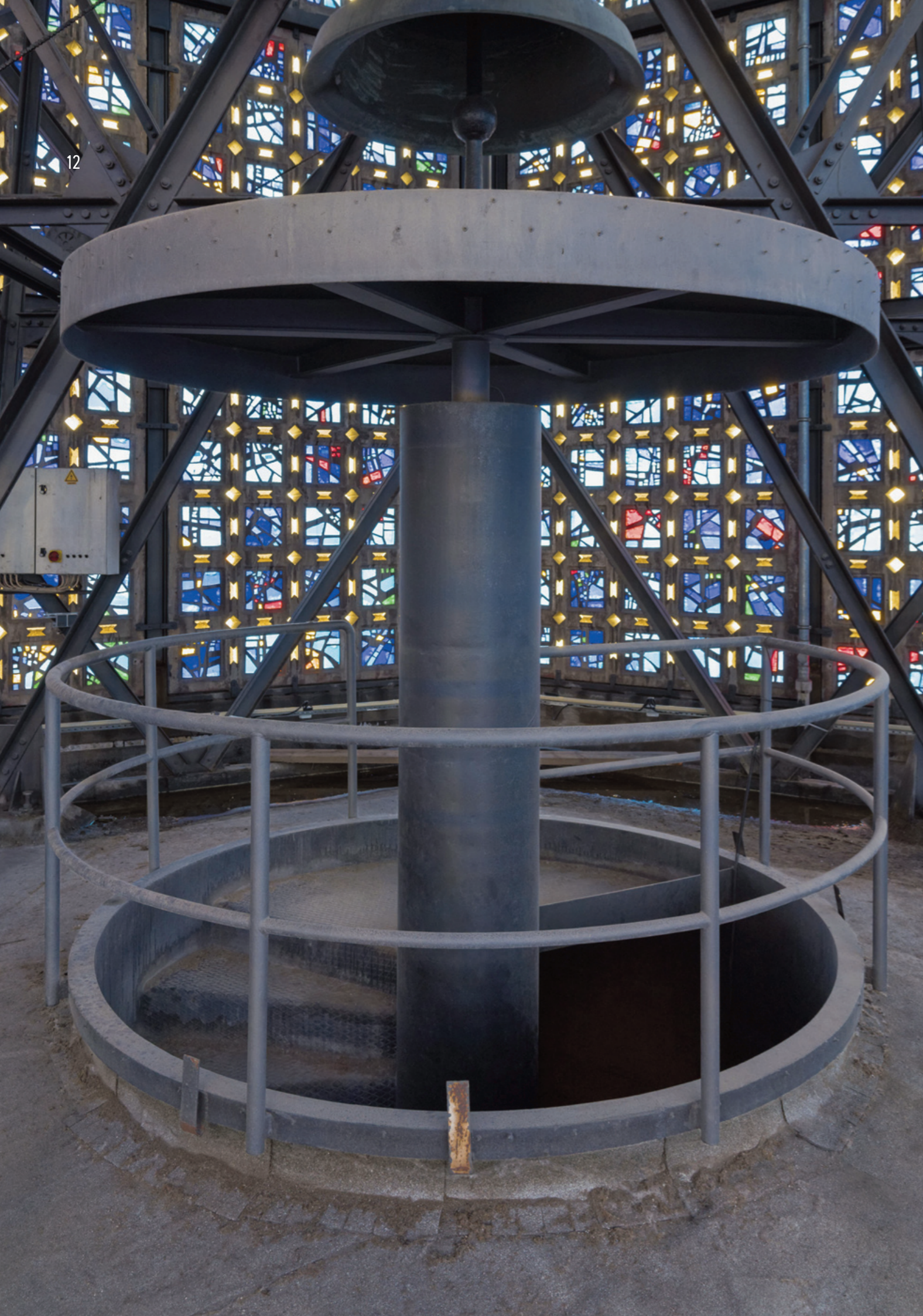
Austritt aus der Röhre im Glockenturm im Bereich der Glockenstube.
